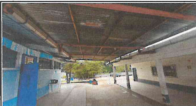
Foto1: Sustitución de lámina acanala por troquelada, en área del corredor principal.
