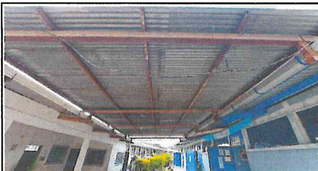
Foto 3: Mantenimiento a estructura de soporte de metal (lijado y pintado) en el área del corredor principal.
