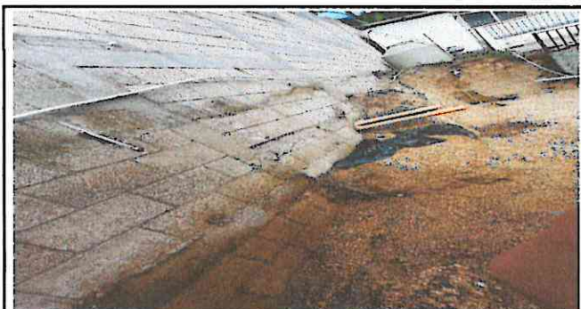
Foto 3: Reparación a muro de contención por peligro a deslizamiento por las constantes lluvias, en área frente a la cocina.
